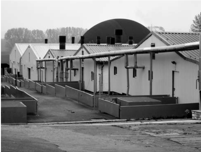
Abb. 1: Stallanlage (weiße Dächer = Neubau)
